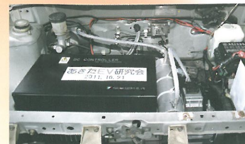
エンジンルーム内に据えられたDCコントロールBOX等
